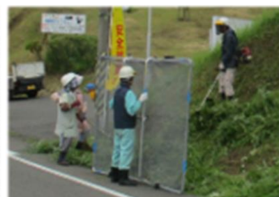
宮之城文化C国道側の作業風景
